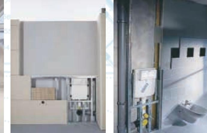
Τοίχος υδραυλικών εγκαταστάσεων Knauf W - 116.
