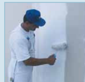
Επάλειψη χρώματος με ρολλό
