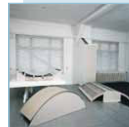
Καμπύλωση γυψοσανίδας σε φόρμα
