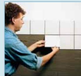
Επικόλληση πλακιδίων με ελαστική κόλλα
