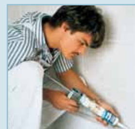
Σφράγιση με σιλικόνη Knauf Normal
