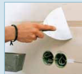
Στοκάρισμα της γυψοσανίδας
