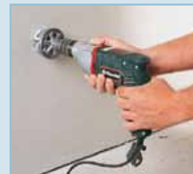
Άνοιγμα εγκοπών για κουτιά ηλεκτρικών εγκαταστάσεων
