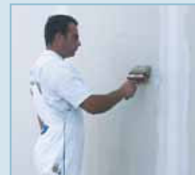
Το αστάρωμα γίνεται με βούρτσα ή ρολλό
