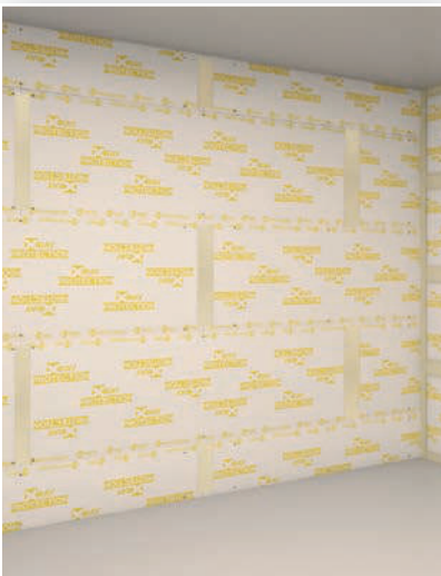
7. Αρμολόγηση κάθετων αρμών 2ης στρώσης
