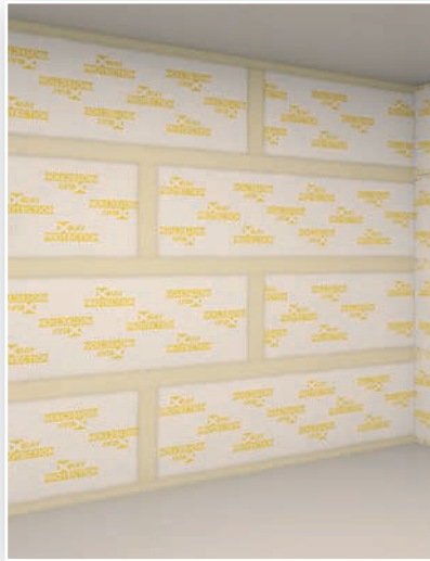
5. Αρμολόγηση οριζόντιων αρμών
