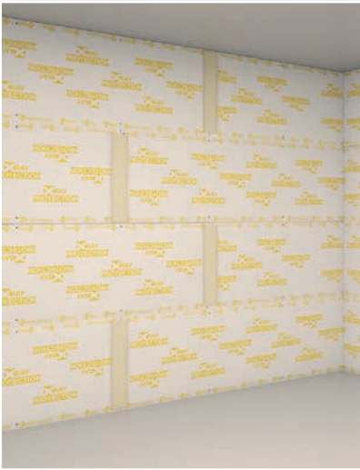
4. Αρμολόγηση κάθετων αρμών
