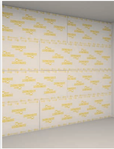
2. Οριζόντια τοποθέτηση γυψοσανίδων
