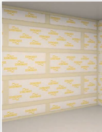
8. Αρμολόγηση οριζόντιων αρμών 2ης στρώσης
